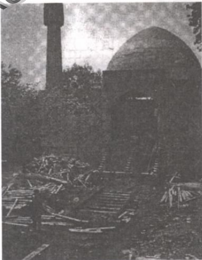
تصویر پایان کار اسکلت ساختمان مسجد
